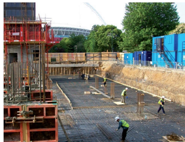
Preparing to pour the watertight floor slab
